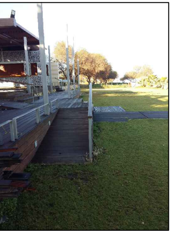
ΦΟΤΟΓΡΑΦΙΑ 3 (πρόσβαση κατασκευής ράμπας ΑμεΑ προς παραλία)
