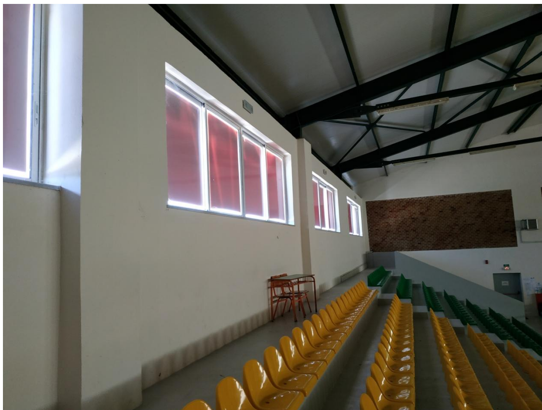
Ανοίγματα δυτικής πλευράς του κτιρίου
