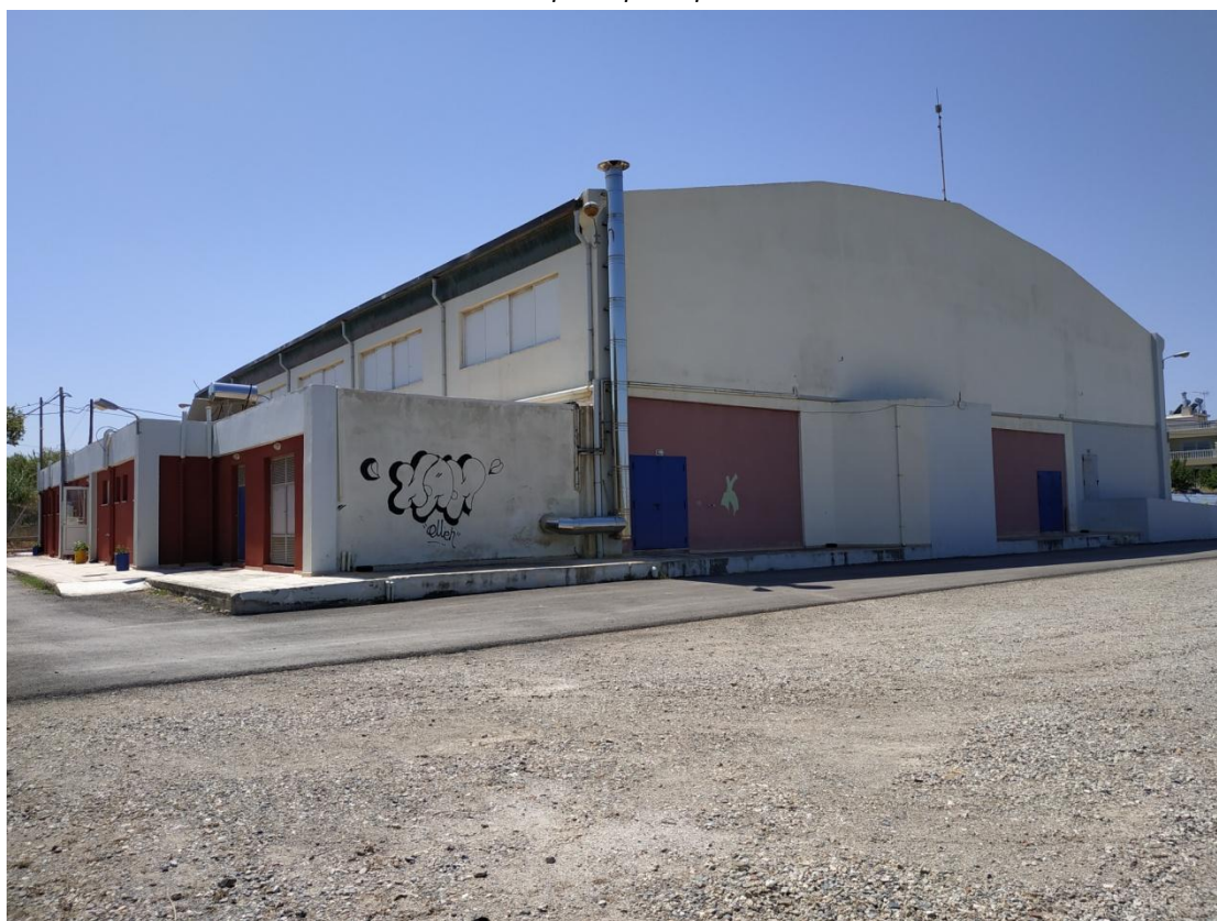
Βόρεια πλευρά κτιρίου
