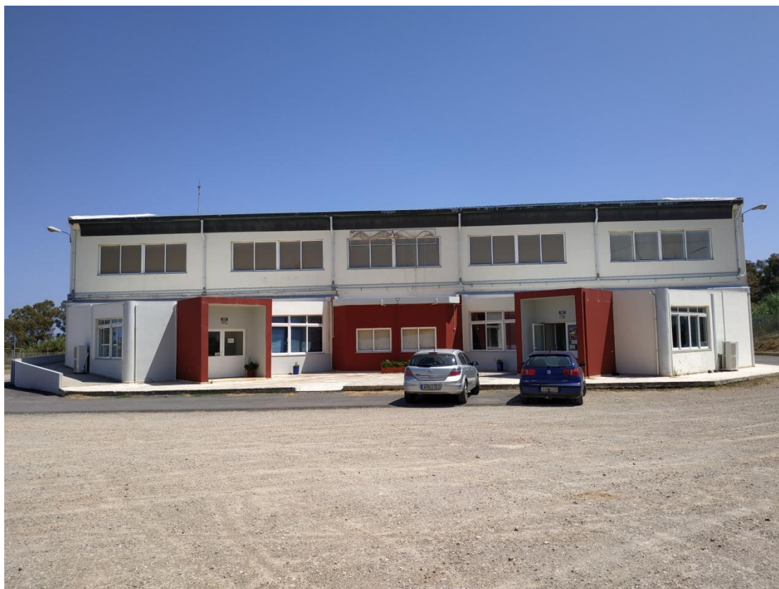
Δυτική πλευρά κτιρίου
