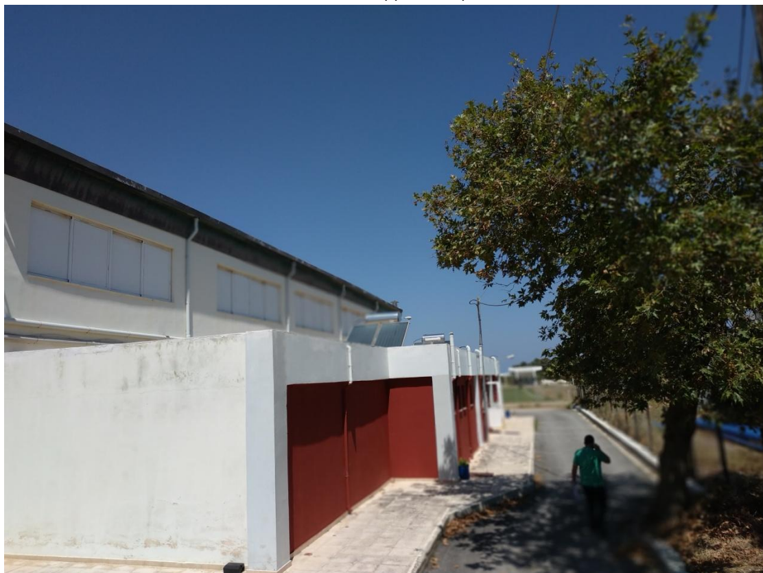
Ανατολική πλευρά κτιρίου
