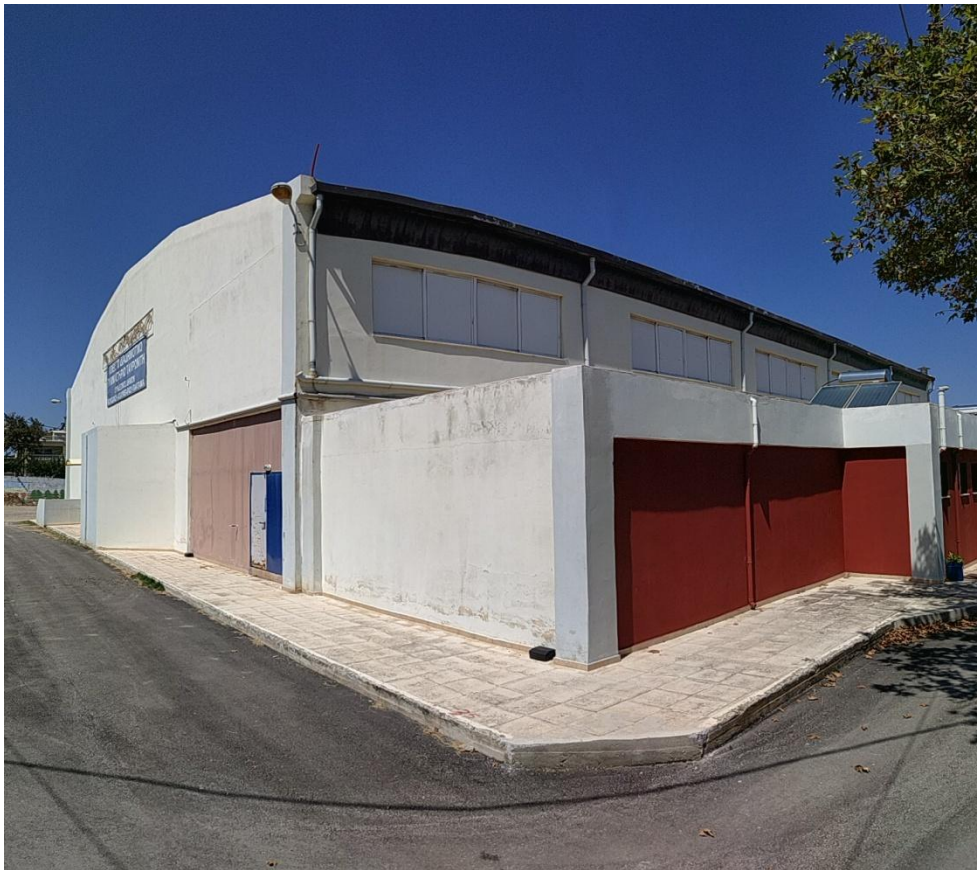
Νοτιοανατολική γωνία κτιρίου
