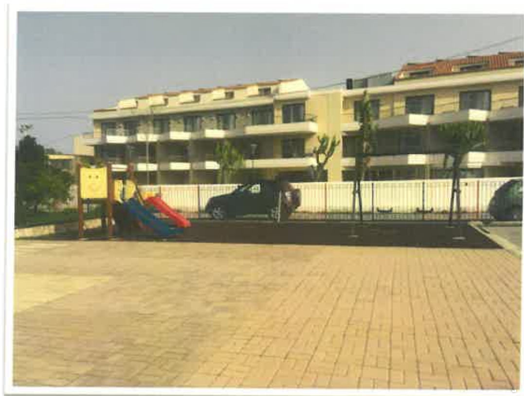
Εικόνα. Εσωτερική όψη χώρου
