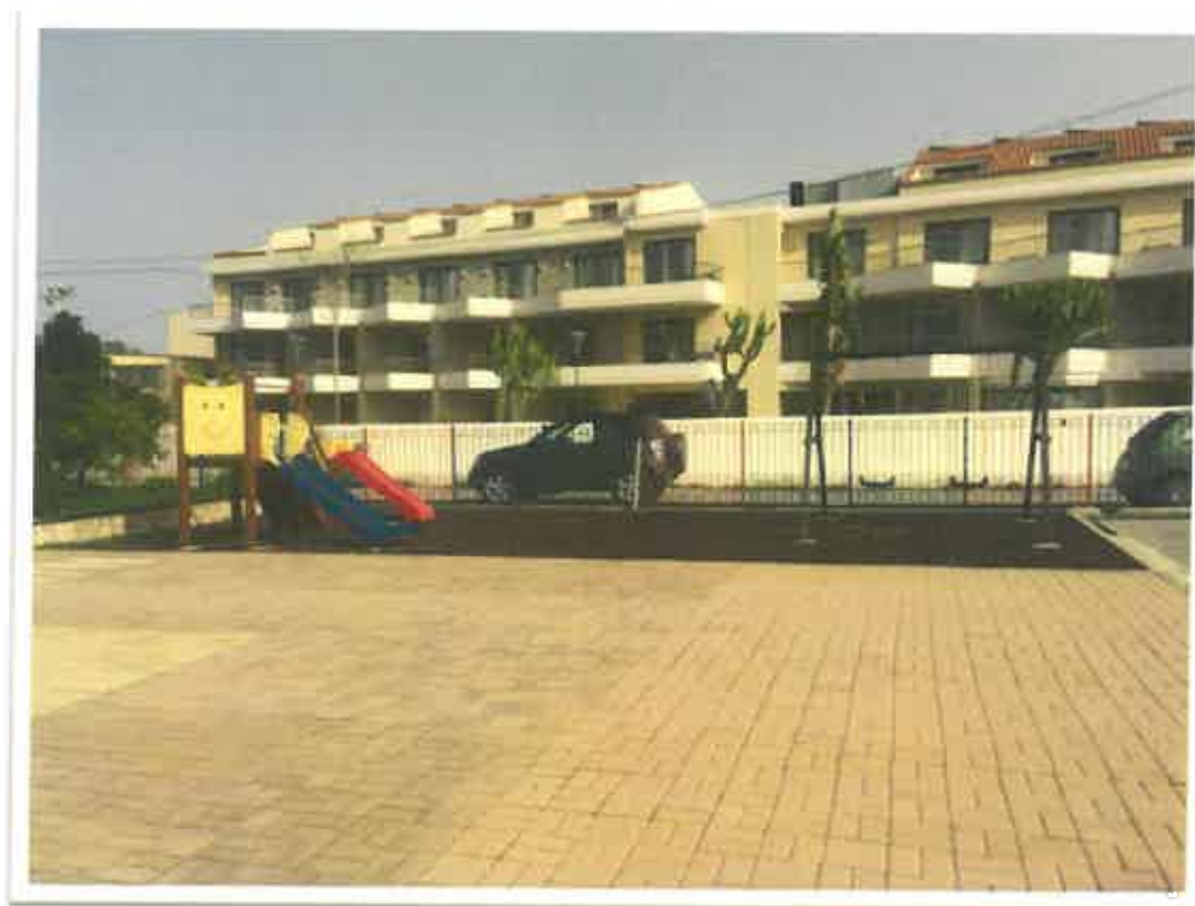
Εικόνα. Εσωτερική όψη χώρου
